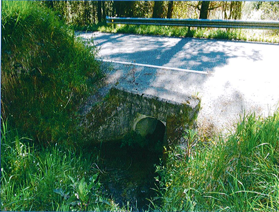
Caño de hormigón ( \text{Ø}_{\text{int}}=0,6 \text{ m.} ) existente.
