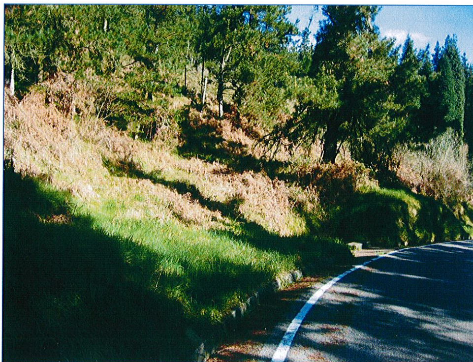
Punto de entronque con la carretera AS-331.
